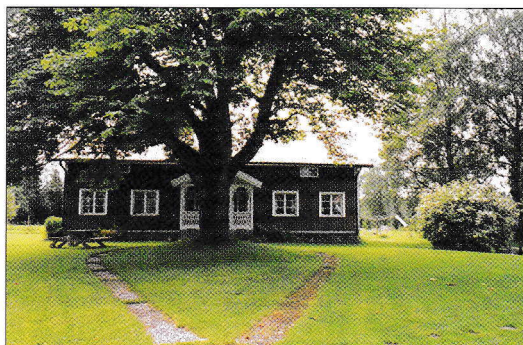
Huvudbyggnaden i Baggekvarn, som idag ägs av Lilian Söderqvist och Bengt Claesson
